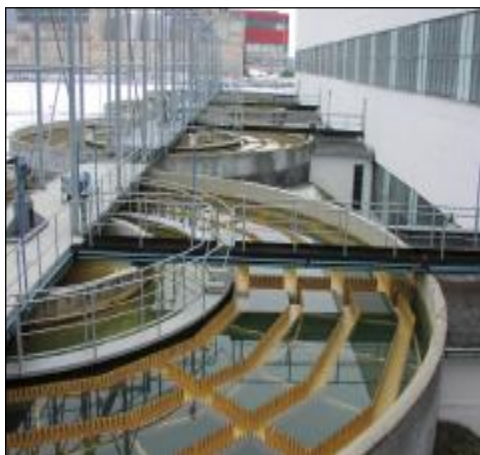
Obr. 1 Prevádzkovanie ěirenia vody Hrona v Atómovej elektrárne Mochovce
