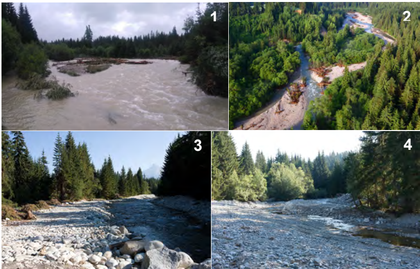
Obr. 1. Rieka Belá v časti Hrdovo 19. júla 2018; 2. Rieka Belá a jej divočiacie a migrujúce koryto; 3. Úpravy koryta rieky Belá nad Kokavským mostom; 4. Úpravy koryta rieky Belá medzi Podbanským a Kokavským mostom (Obr. 1, 3, 4 © Andrea Rúfusová; Obr. 2 © Arolla Film).
